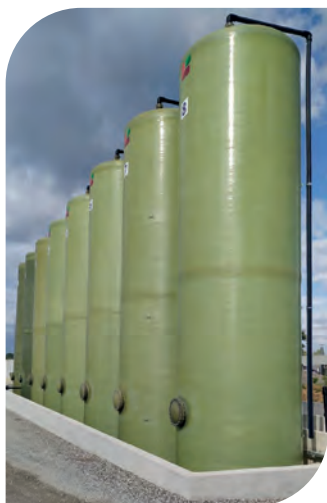
Cisterna in vetroresina con base piatta per prodotti liquidi (produzione con tecnica a filamento continuo) capacità 80 000 L
