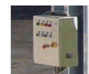
Quadro comando per azionamento serranda elettropneumatica Control board for the operation of the electro-pneumatic sliding gate Boitier d'actionnement de la trappe électro-pneumatique Schalttafel für die Steuerung des elektropneumatischen Absperrschiebers Щиток для управления электропневматическим шиберным затвором
